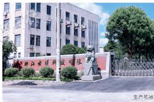
未来大楼(在建中)
